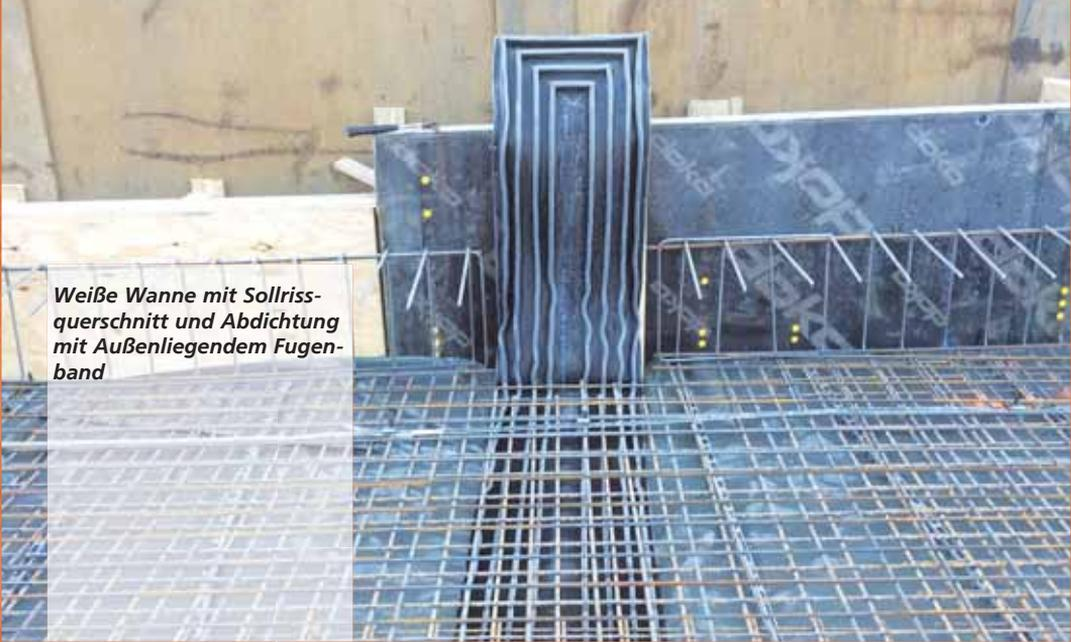
**Weißer Wanne mit Sollrissquerschnitt und Abdichtung mit Außenliegendem Fugenband**
