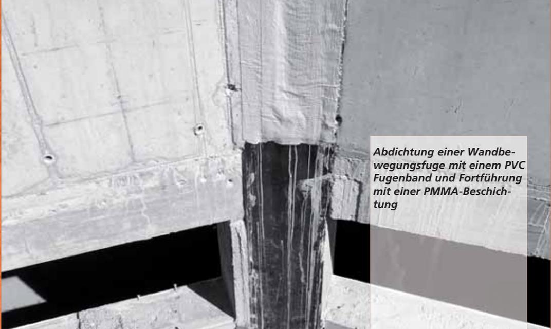
*Abdichtung einer Wandbewegungsfuge mit einem PVC Fugenband und Fortführung mit einer PMMA-Beschichtung*
