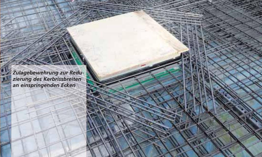
**Zulagebewehrung zur Reduzierung des Kerbrissbreiten an einspringenden Ecken**
