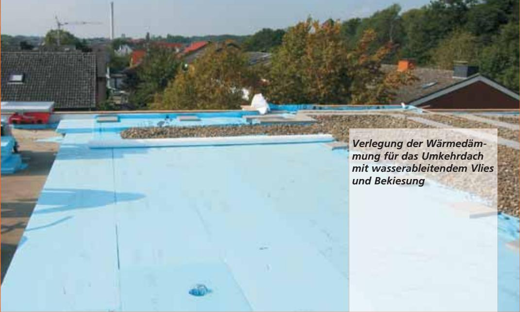
*Verlegung der Wärmedämmung für das Umkehrdach mit wasserableitendem Vlies und Bekiesung*
