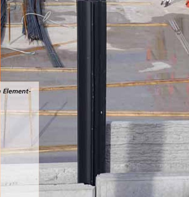
**Dichtungsrohr im Elementplattenstoß**
