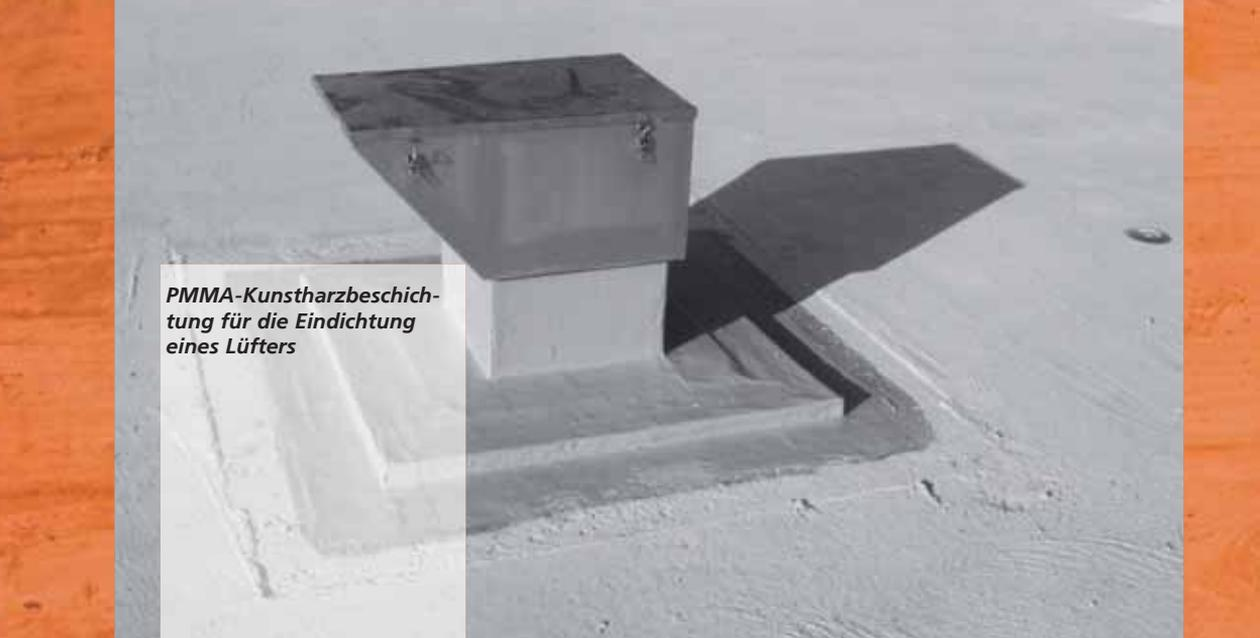
**PMMA-Kunsthartzbeschichtung für die Eindichtung eines Lüfters**
