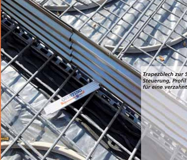
*Trapezblech zur Sollriss-Steuerung, Profil gem. EC 2 für eine verzahnte Fuge*
