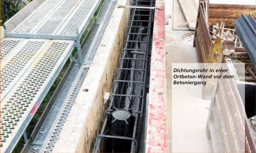
*Dichtungsrohr in einer
