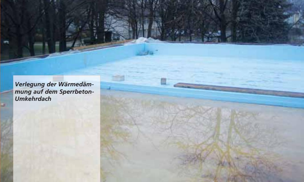
**Verlegung der Wärmedämmung auf dem Sperrbeton-Umkehrdach**
