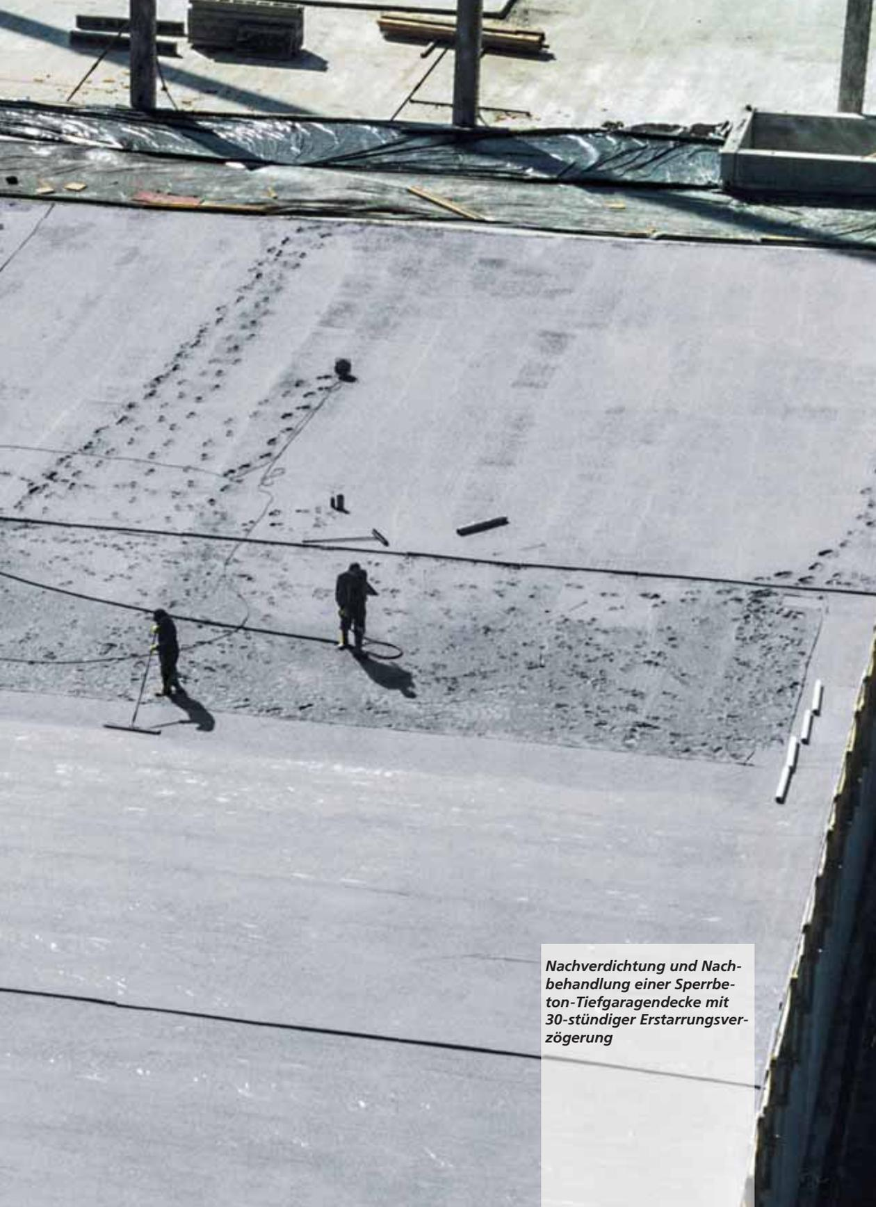
*Nachverdichtung und Nachbehandlung einer Sperrbeton-Tiefgaragendecke mit 30-stündiger Erstarrungsverzögerung*
