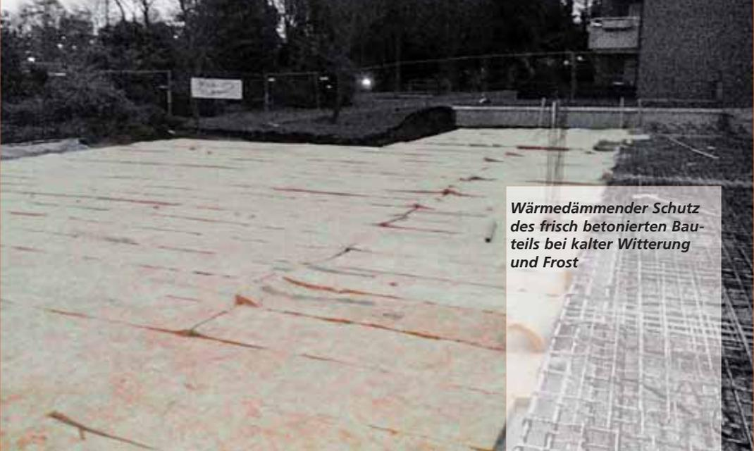
**Wärmedämmender Schutz des frisch betonierten Bauteils bei kalter Witterung und Frost**
