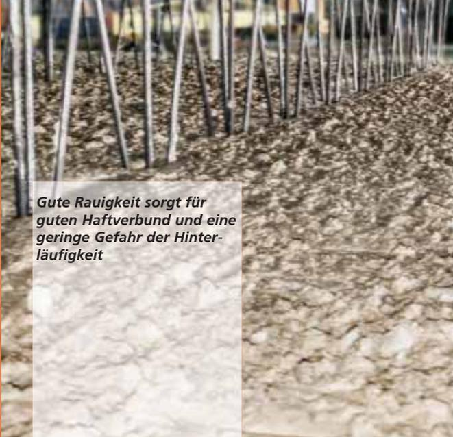
*Gute Rauigkeit sorgt für guten Haftverbund und eine geringe Gefahr der Hinterläufigkeit*
