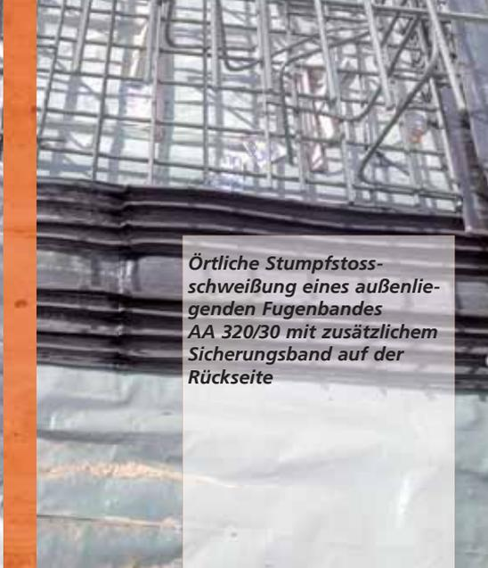
*Örtliche Stumpfstoss-schweißung eines außenliegenden Fugenbandes AA 320/30 mit zusätzlichem Sicherungsband auf der Rückseite*
