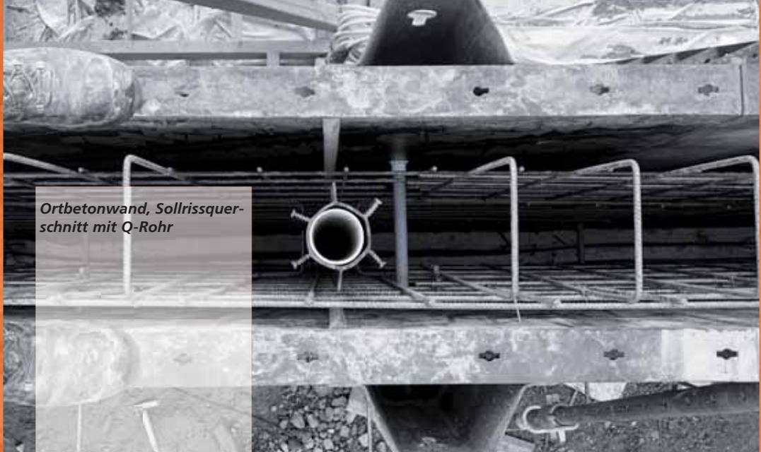
*Ortbetonwand, Sollrissquerschnitt mit Q-Rohr*
