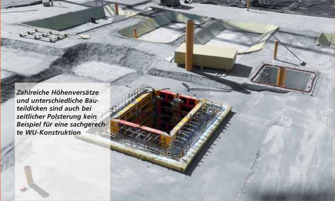
*Zahlreiche Höhenversätze und unterschiedliche Bauteildicken sind auch bei seitlicher Polsterung kein Beispiel für eine sachgerechte WU-Konstruktion*
