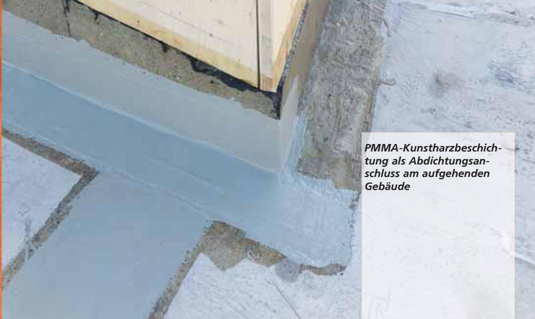
**PMMA-Kunstharzbeschichtung als Abdichtungsanschluss am aufgehenden Gebäude**
