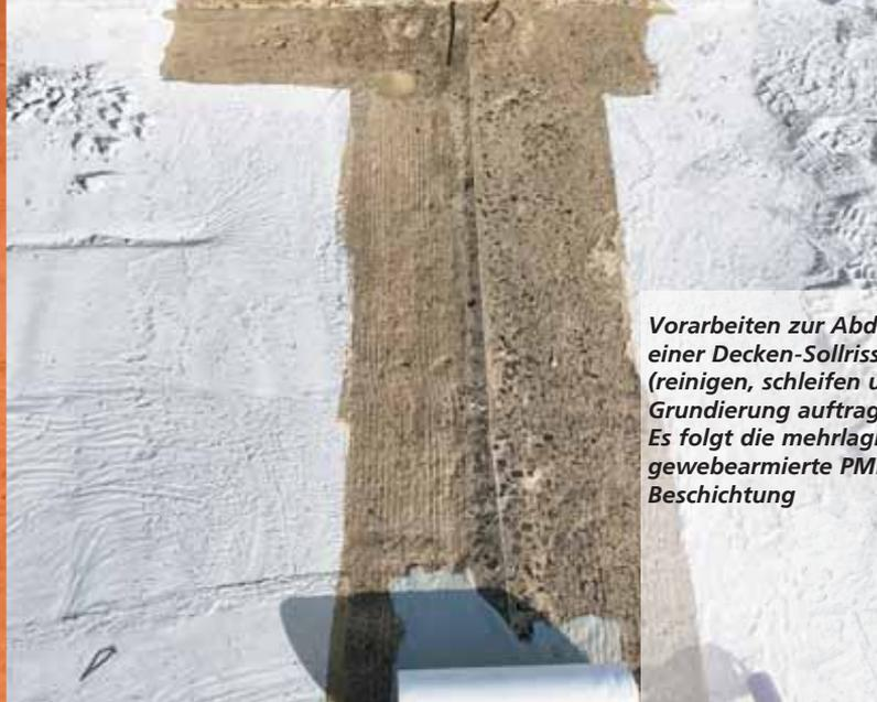
**Vorarbeiten zur Abdichtung einer Decken-Sollrissfuge (reinigen, schleifen und Grundierung auftragen). Es folgt die mehrlagige gewebearmierte PMMA-Beschichtung**
