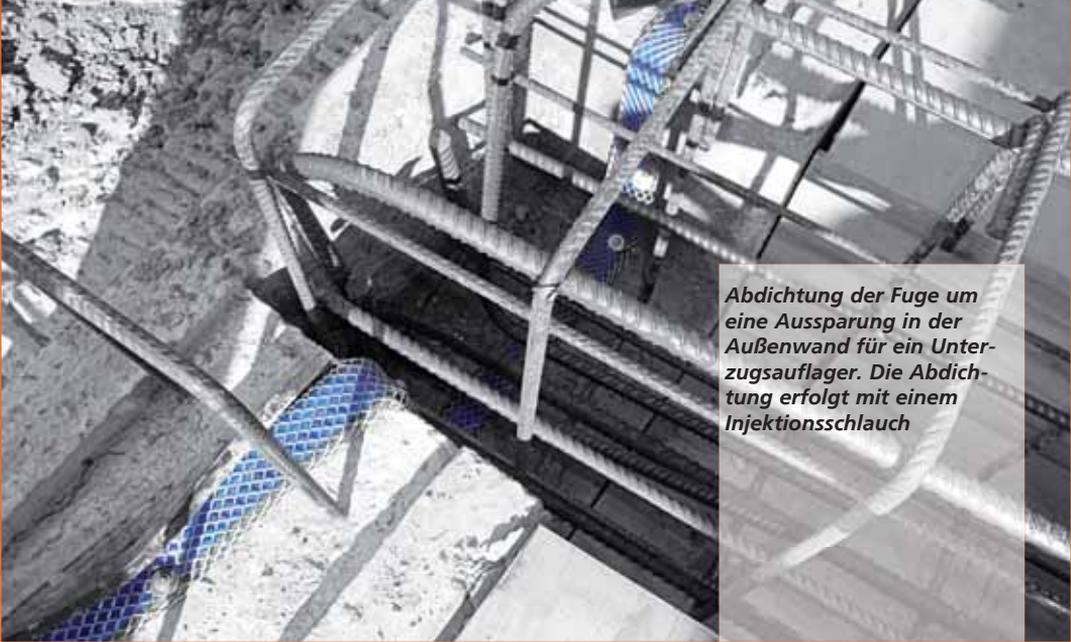
*Abdichtung der Fuge um eine Aussparung in der Außenwand für ein Unterzugsauflager. Die Abdichtung erfolgt mit einem Injektionsschlauch*
