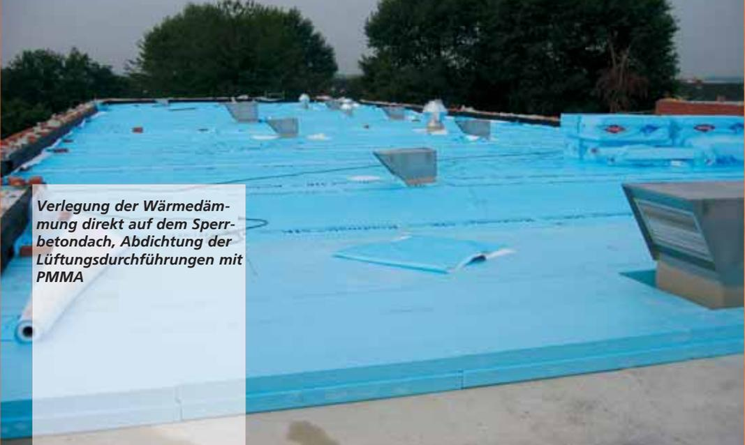
**Verlegung der Wärmedämmung direkt auf dem Sperrbetondach, Abdichtung der Lüftungsdurchführungen mit PMMA**
