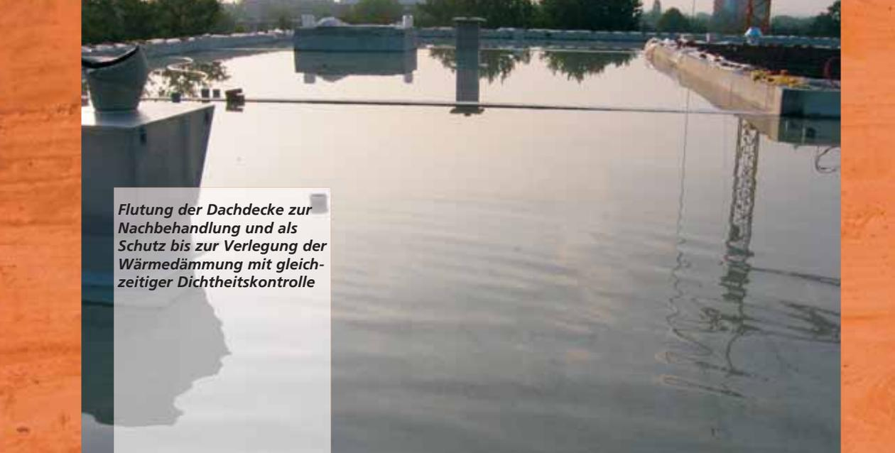
**Flutung der Dachdecke zur Nachbehandlung und als Schutz bis zur Verlegung der Wärmedämmung mit gleichzeitiger Dichtheitskontrolle**
