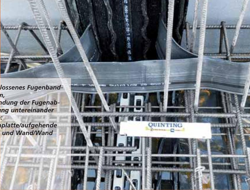
**Geschlossenes Fugenbandsystem, Verbindung der Fugenabdichtung untereinander Fugen:
